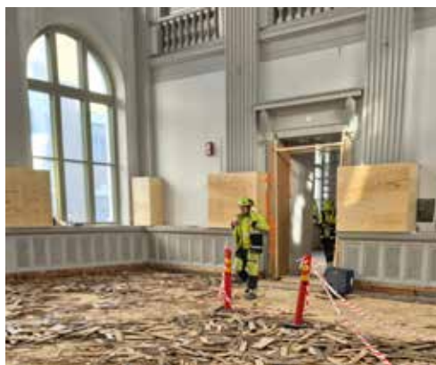
För tillfället handlar arbetena i GRO främst om att riva. Den gamla festsalen ska förvandlas till hyresgästernas vardagsrum.
