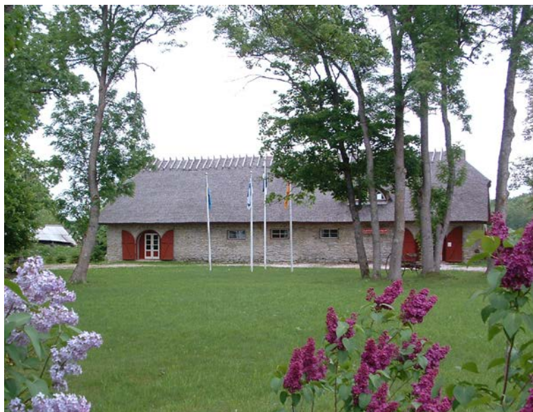
Den restaurerade ekonomiebyggnaden vid Lyckholmens herrgård har gjorts till ett hembygdsmuseum för Nuckö. De vackert lagda vasstaket följer gamla traditioner i svenskbygden.
